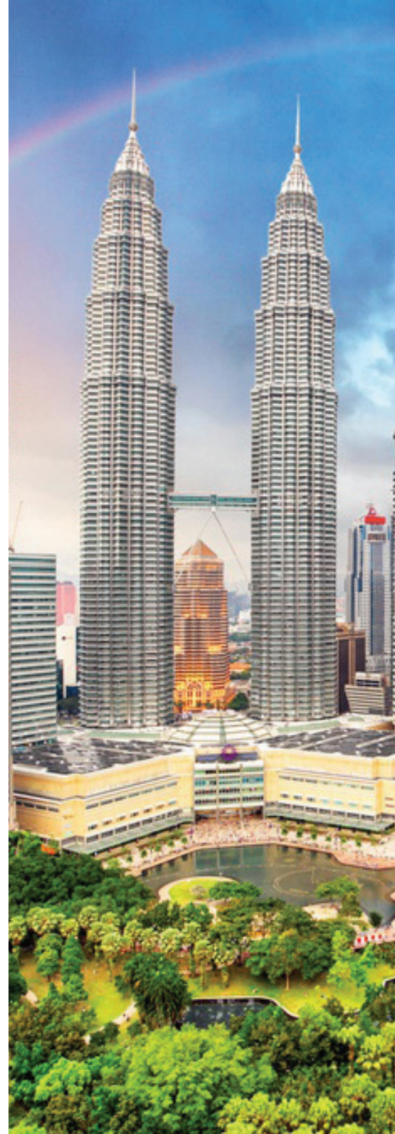
อาคารหอคอยคู่เปโตรนาส (Petronas Twin Towers)
