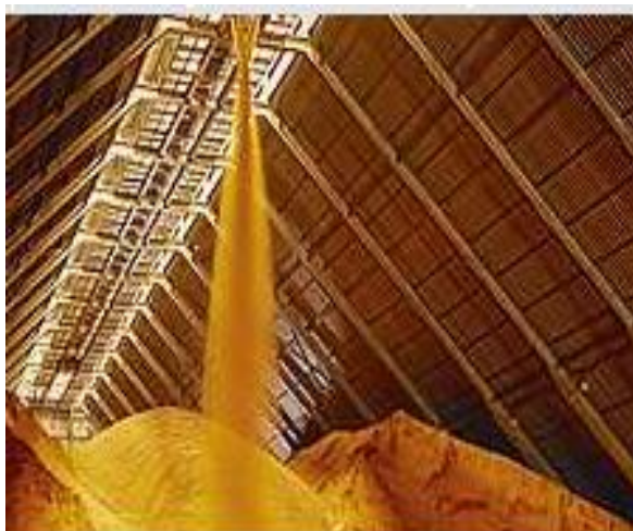
น้ำตาลทรายดิบขนเข้าเก็บในโกดัง และขนส่งเรือโดยระบบสายพานลำเลียง
