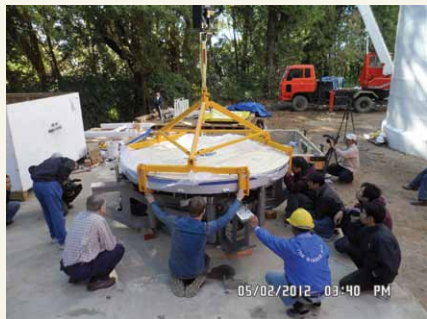
การยกกล้องโทรทรรศน์ ซึ่งมีน้ำหนักถึง 17 ตัน เข้าไปในโดม ซึ่งต้องใช้เครนที่สามารถยกน้ำหนักได้ถึง 120 ตัน เพื่อยกกล้องโทรทรรศน์ขึ้นไปถึงความสูงมากกว่า 20 เมตร
