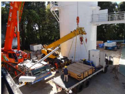
การยกกล้องโทรทรรศน์ ซึ่งมีน้ำหนักถึง 17 ตัน เข้าไปในโดม ซึ่งต้องใช้เครนที่สามารถยกน้ำหนักได้ถึง 120 ตัน เพื่อยกกล้องโทรทรรศน์ขึ้นไปถึงความสูงมากกว่า 20 เมตร
