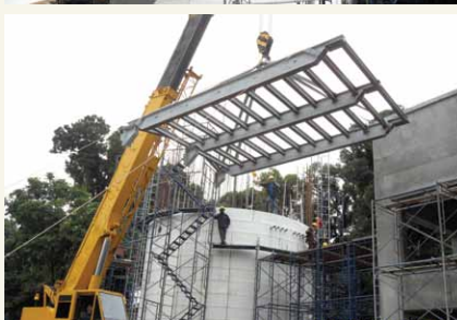
การประกอบโครงสร้างโดม เริ่มดำเนินการในเดือน กรกฎาคม พ.ศ. 2554
