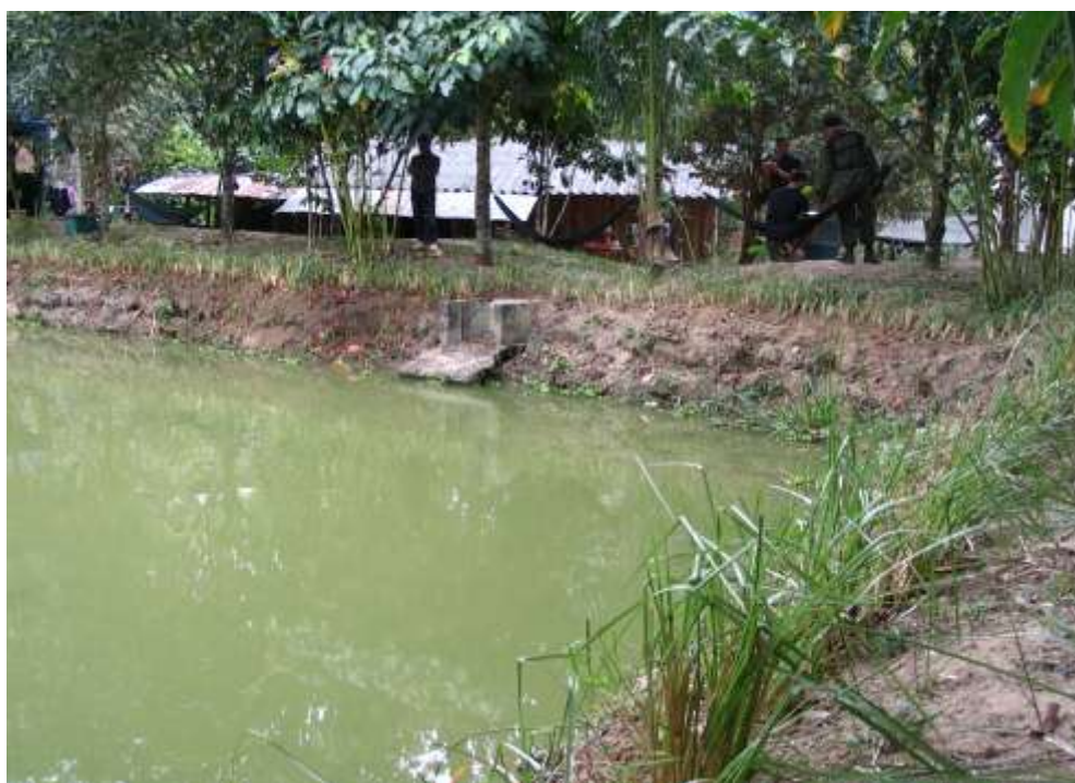
ภาพที่ 4.15 การปลูกหญ้าแฝกเพื่อป้องกันการพังทลายของดินบริเวณขอบสระน้ำ
