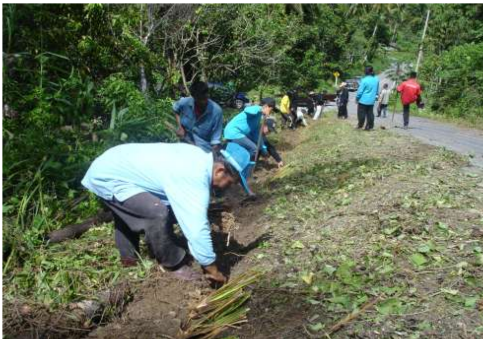
ภาพที่ 4.5 การรณรงค์ปลูกหญ้าแฝกบริเวณไหล่ถนน
