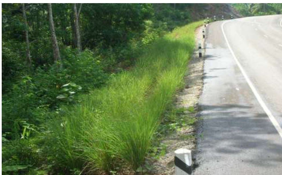
ภาพที่ 3.17 การปลูกหญ้าแฝกพื้นที่ไหล่ถนน
