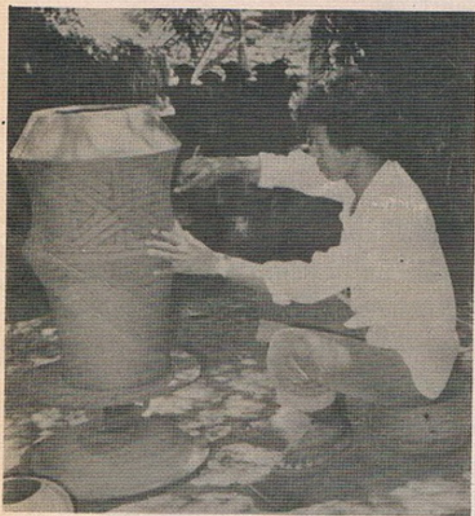
← ภาพที่ 12 การตกแต่งลวดลายด้วยวิธีขูดดิน
