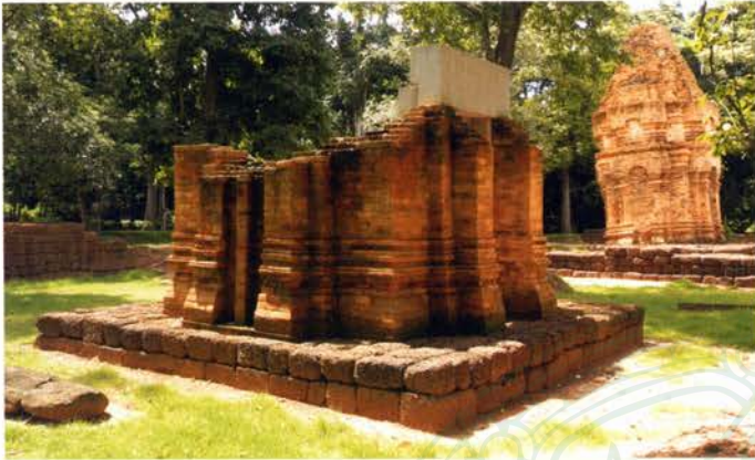
ปราสาทหมายเลข 2 โบราณสถานปรางค์ฤๅษี ภายหลังการบูรณะ Tower No. 2 at Prang Ruesi monument after restoration.
