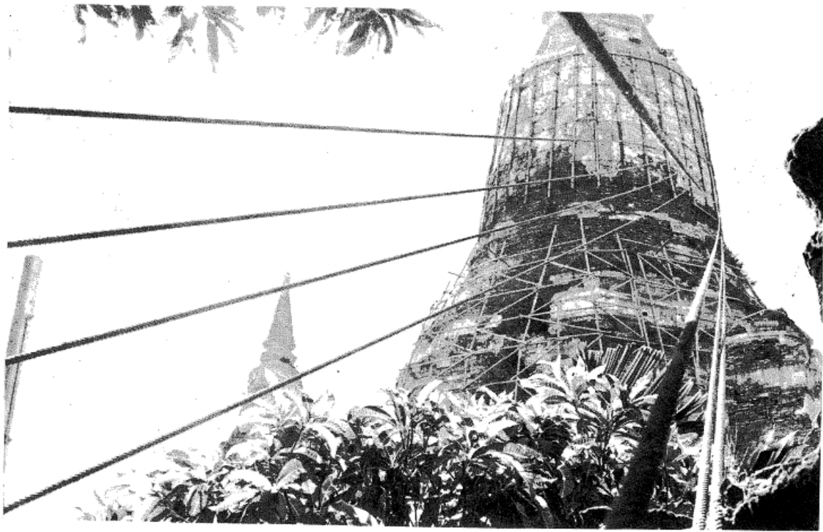
การใช้ลวดสลิงรัดรอบองค์ระฆัง และตั้งรับมาทางทิศตะวันออก เพื่อป้องกันการทรุดเอียง
