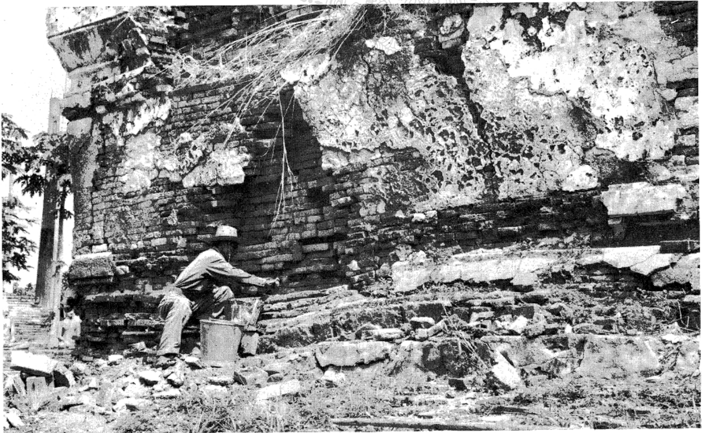
รูปที่ ๔ มุมฐานเจดีย์ ด้านทิศใต้ ก่อนบูรณะ
