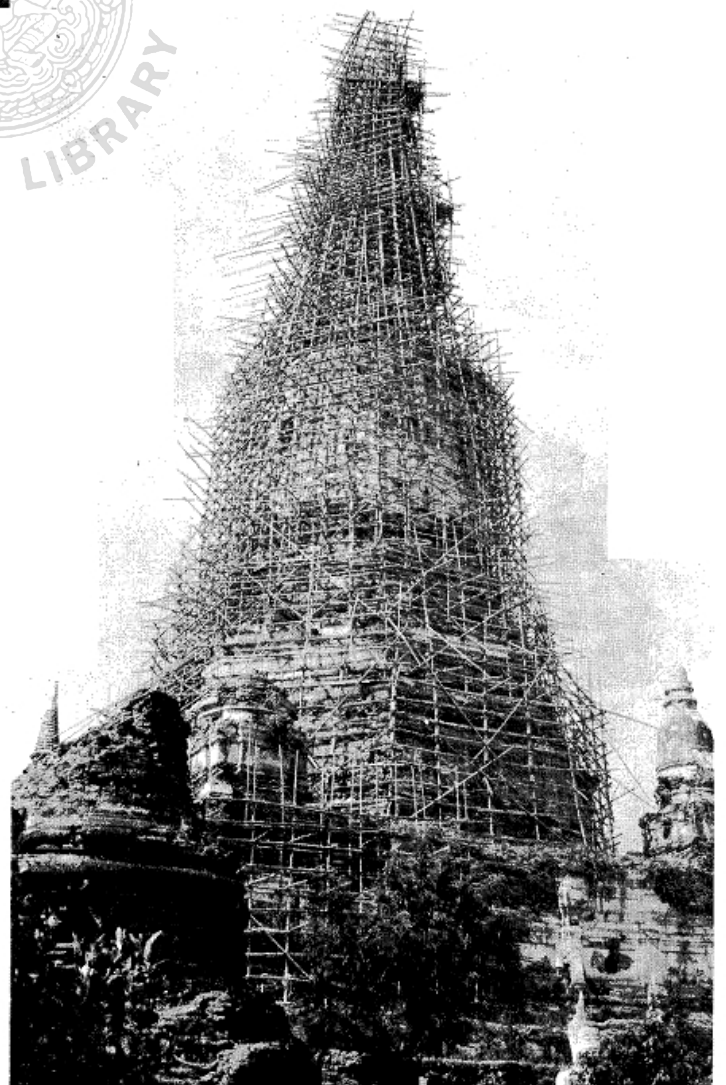
รูปที่ ๒ ใช้ไม้ไผ่ผูกนั่งร้านจากฐานถึงยอดเจดีย์ เพื่อ บูรณะยอดเจดีย์ บัลลังก์แปดเหลี่ยม และ องค์ระฆัง
