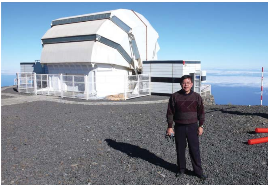
อาคารหอดูดาวรูปทรงเปลือกหอย (Clamshell Enclosure) ติดตั้งกล้องโทรทรรศน์ขนาดเส้นผ่านศูนย์กลาง 2.0 เมตร ของมหาวิทยาลัยลิเวอร์พูล จอห์นเบียร์ ที่หอดูดาว Observatorio del Roque de los Muchachos เกาะลาปาลมา (La Palma) สเปน
