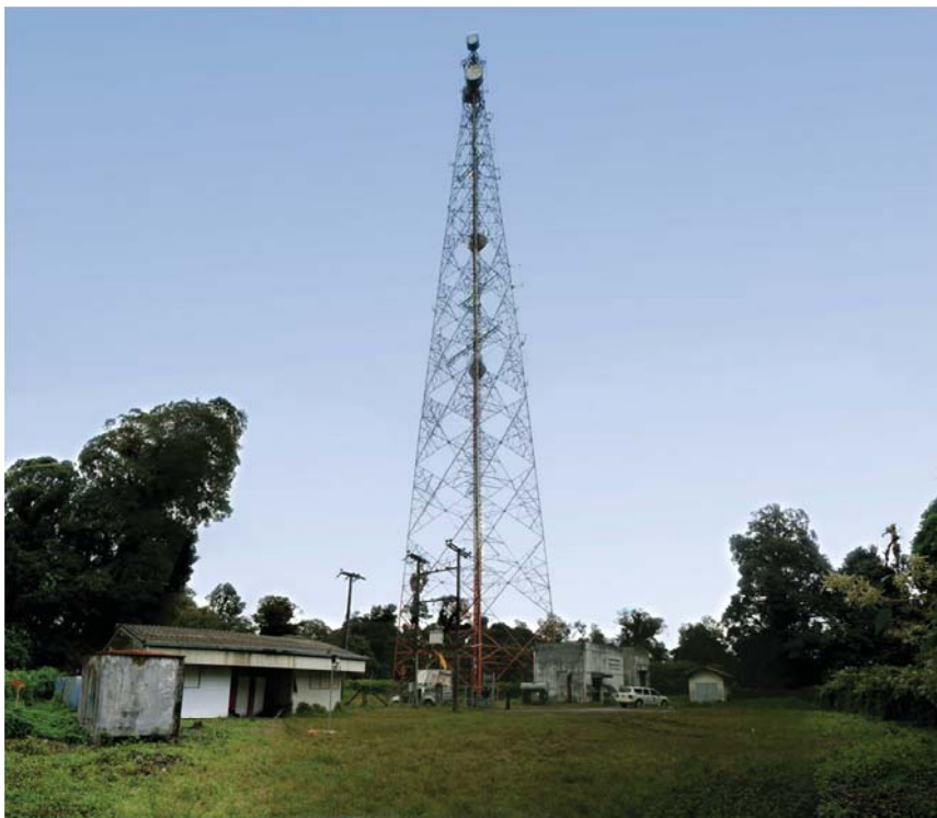
บริเวณสถานีทวนสัญญาณไอที จ้ากัด (มหาชน) กม.44.4 อุทยานแห่งชาติดอยอินทนนท์ อำเภอจอมทอง จังหวัดเชียงใหม่
