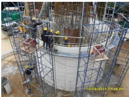
การสร้างผนังวงแหวนโดยใช้โครงสร้างคอนกรีตเสริมเหล็ก และแผ่นไฟเบอร์กลาสเป็นแม่พิมพ์ในการเทคอนกรีต
