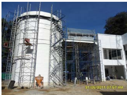
การสร้างผนังวงแหวนโดยใช้โครงสร้างคอนกรีตเสริมเหล็ก และแผ่นไฟเบอร์กลาสเป็นแม่พิมพ์ในการเทคอนกรีต
