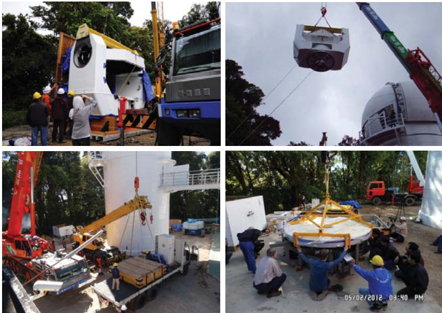
การยกกล้อโทรทรรศน์ ซึ่งมีน้ำหนักถึง 17 ตัน เข้าไปในโดม ซึ่งต้องใช้เครนที่สามารถยกน้ำหนักได้ถึง 120 ตัน เพื่อยกกล้อโทรทรรศน์ขึ้นไปถึงความสูงมากกว่า 20 เมตร
