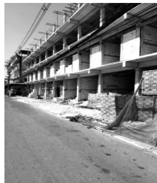
ภาพที่ 1 อาคารพาณิชย์ที่ก่อผนังด้วยคอนกรีตมวลเบา
