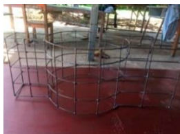
(c) โครงหลักยึดปูนหล่อตัวเตา
