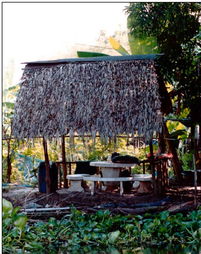
รูปที่ 2-5 ใบจากใช้เป็นวัสดุมุงหลังคาที่ยังเป็นที่นิยมอยู่ในปัจจุบัน
