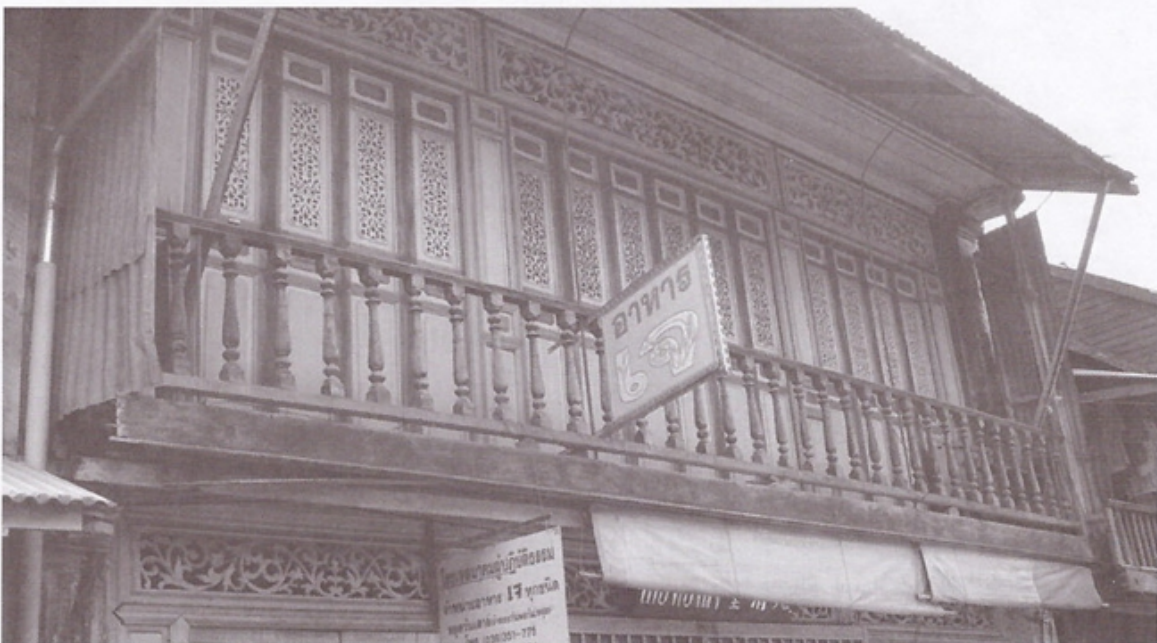
▲ อาคารที่มีลักษณะแบบเรือนแถว บริเวณท่าหลวง
