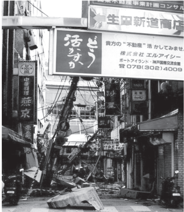
รูปอาคารในเมืองโกเบประเทศญี่ปุ่น ได้รับความเสียหายจากแผ่นดินไหว
