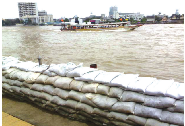
รูปการป้องกันน้ำท่วมโดยการใช้กระสอบทรายกันตามแนวแม่น้ำ
