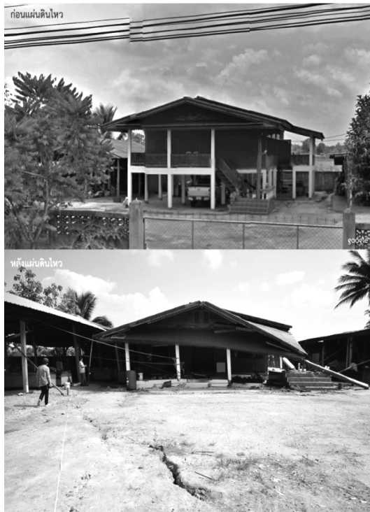
รูปเปรียบเทียบก่อนและหลังเกิดแผ่นดินไหว ที่เกิดกับบ้านราษฎรหลังหนึ่ง
