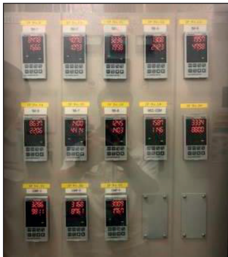
ภาพที่ 4 เครื่องวัดการใช้พลังงานไฟฟ้า
