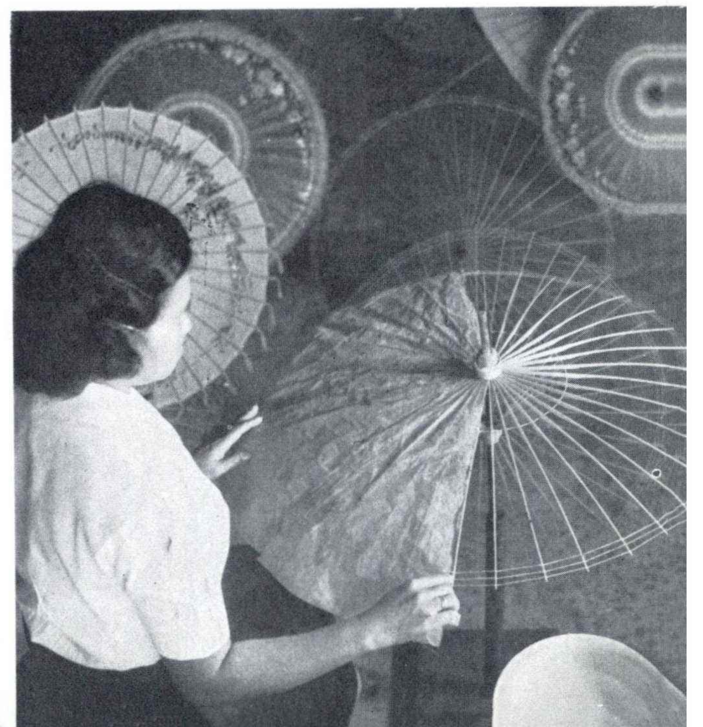
▲ ทำโครงร่มไม้ไผ่ด้วยความชำนาญ และ ซี่ร่มจะเข้าด้วยกัน Umbrella ribs are being strung together.
