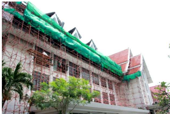
การเปลี่ยนหลังคาอาคารเก่า
