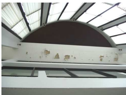
การเปลี่ยนหลังคา และฝ้าเพดาน ชั้น ๓ บริเวณโดมด้านใน
