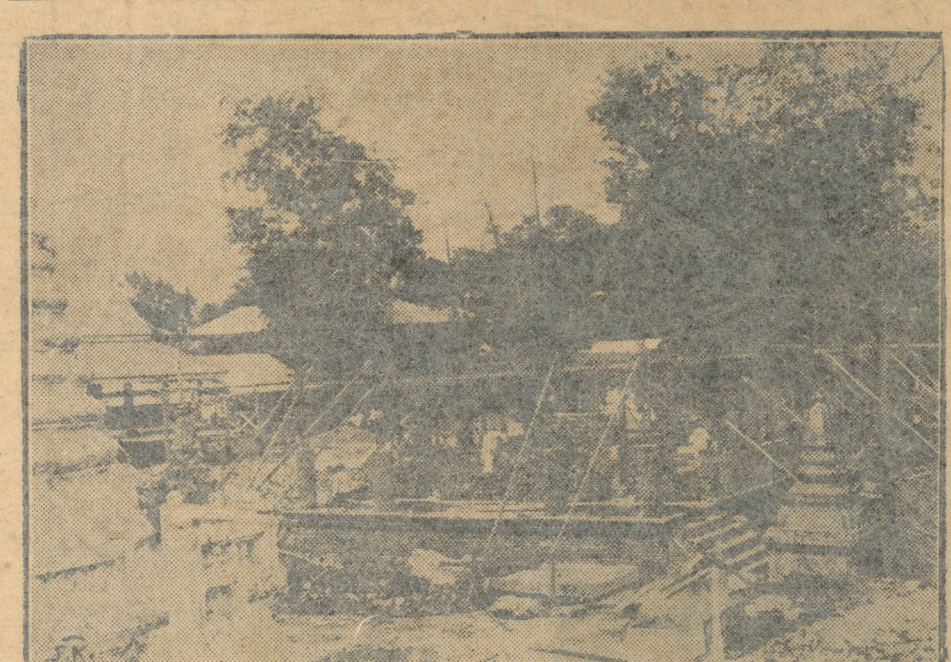
โบสถ์ วัดข้างล่างกำลังรื้อถอนทั้งหมดเพื่อสร้างใหม่ยังขาดเงินอุดหนุน ๖,๐๐๐ บาท
