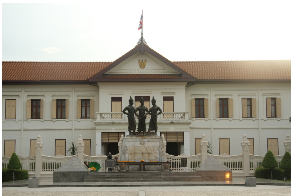
อนุสาวรีย์สามกษัตริย์ อำเภอเมือง จังหวัดเชียงใหม่ การแก้ปัญหาโดยการย้ายเสาธงไปติดตั้งไว้บนอาคาร
