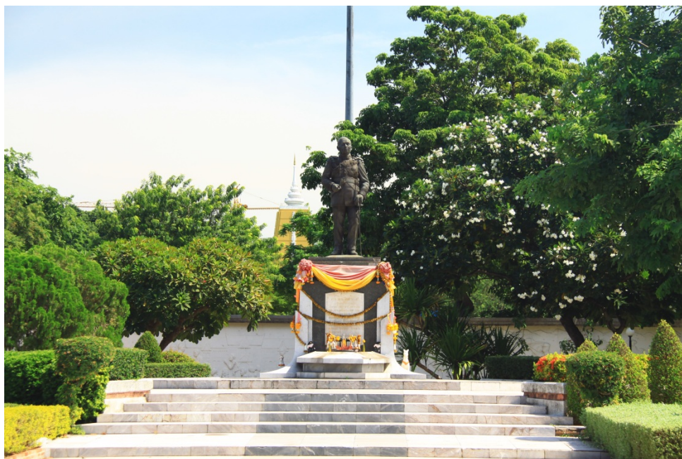
อนุสาวรีย์จอมพลสฤษดิ์ ธนะรัชต์ สวนสาธารณะ อำเภอเมือง จังหวัดขอนแก่น แสดงถึงการก่อสร้างเสาไฟแสงสว่างเพิ่มเติมภายหลังที่ไม่ได้คำนึงถึงผลกระทบต่อสภาพแวดล้อม ทำให้ทำลายความสง่างามของอนุสาวรีย์
