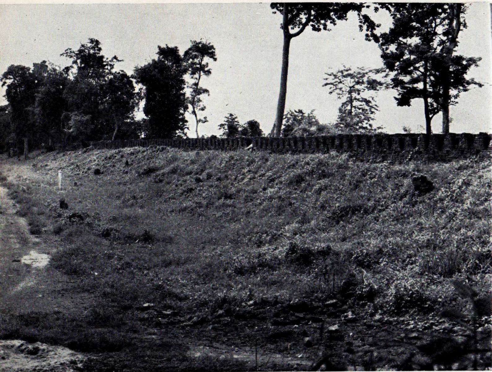
กำแพงเมืองกำแพงเพชร ด้านทิศตะวันตกเฉียงใต้บูรณะแล้ว
