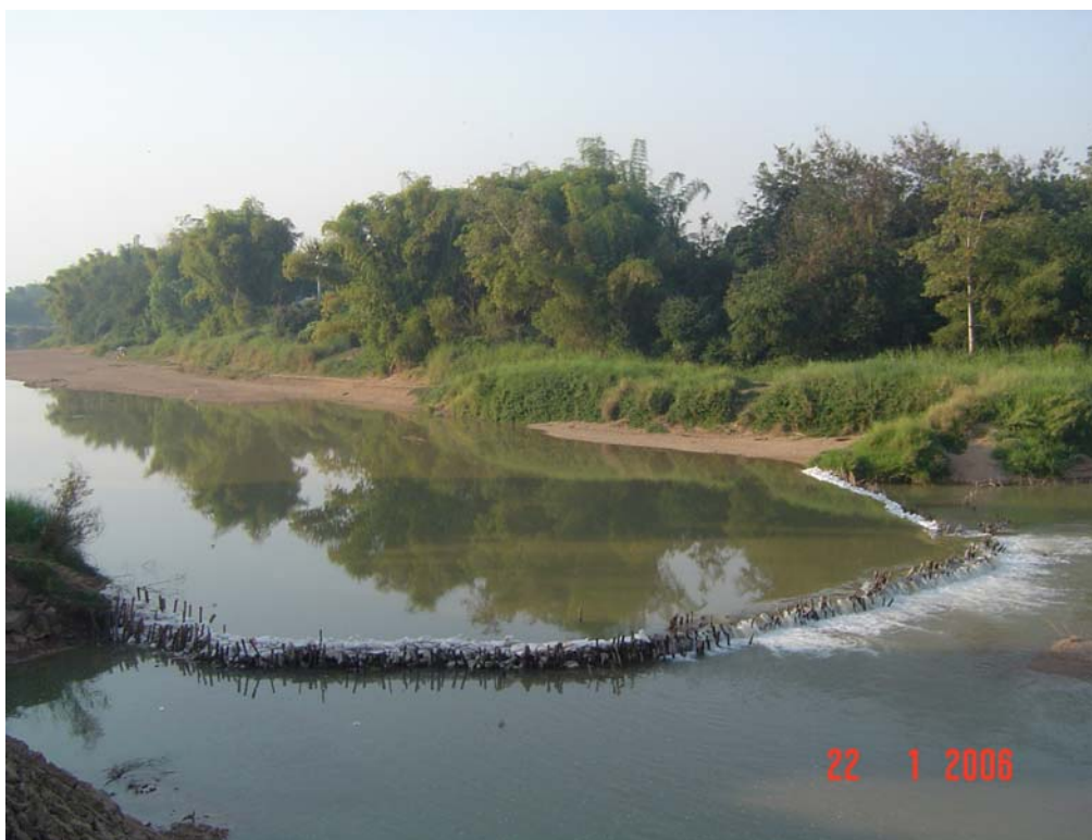
รูปที่ 7 ทำนบกระสอบทรายชั่วคราวปิดกั้นแม่น้ำยม
